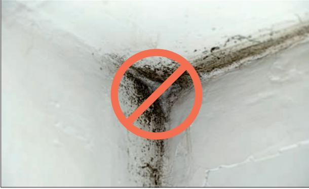
Durch die verbesserte Dichtigkeit des Garagen-Sektionaltors kann es bei ungünstigen Klimaverhältnissen zu Feuchtigkeit und somit zu Schimmel in der Garage kommen. Eine regelmäßige Belüftung ist in diesen Fällen notwendig, um die Luftfeuchtigkeit zu regulieren.
